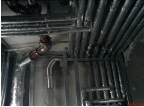
Da die Wasser- und Heizungsrohre schon vollständig verlegt sind und nach neusten Wärme- und Schallschutzvorgaben isoliert wurden (alle Rohre glänzen silbrig in ihren Isolierwolle-Aluminiumhüllen), haben im Januar die **Trockenbauer** damit begonnen, die kilometerlangen „Nervenbahnen“ (Kabel) und Versorgungsgefäße (Wasserleitungen) gewissermaßen mit dem bergenden „Fett- und Bindegewebe“ zu versehen. Sie verkleiden die ganze Technik und erstellen damit die „Innen-
