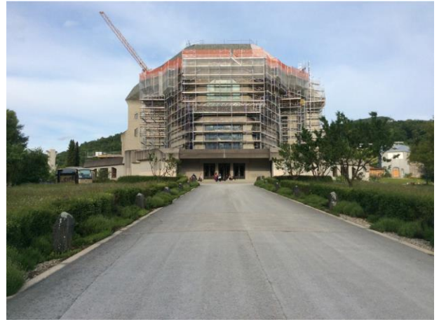
Das Goetheanum mit Gerüst
